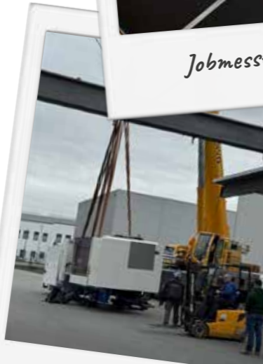
Anlieferung neue Maschine
